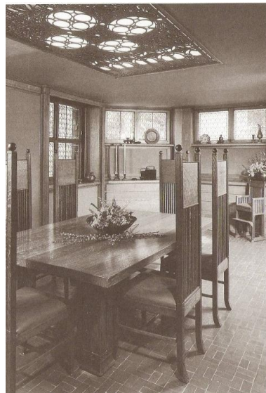
Figura 17. Detalle de carpintería: celosía para plafón que funciona como tragaluz, diseñada por Frank Lloyd Wright. 63
